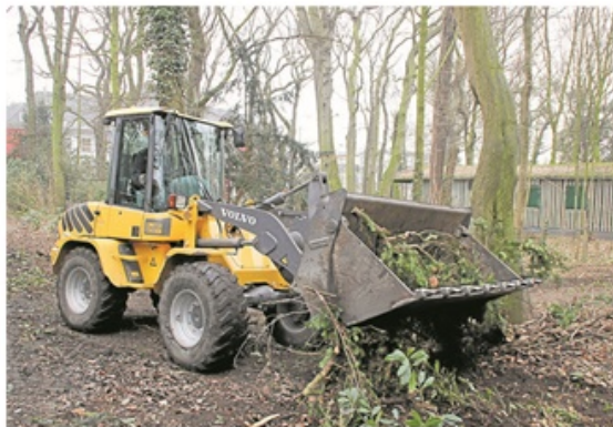
Mit einem Bagger wurden die aufgelesen Holzreste abtransportiert.
