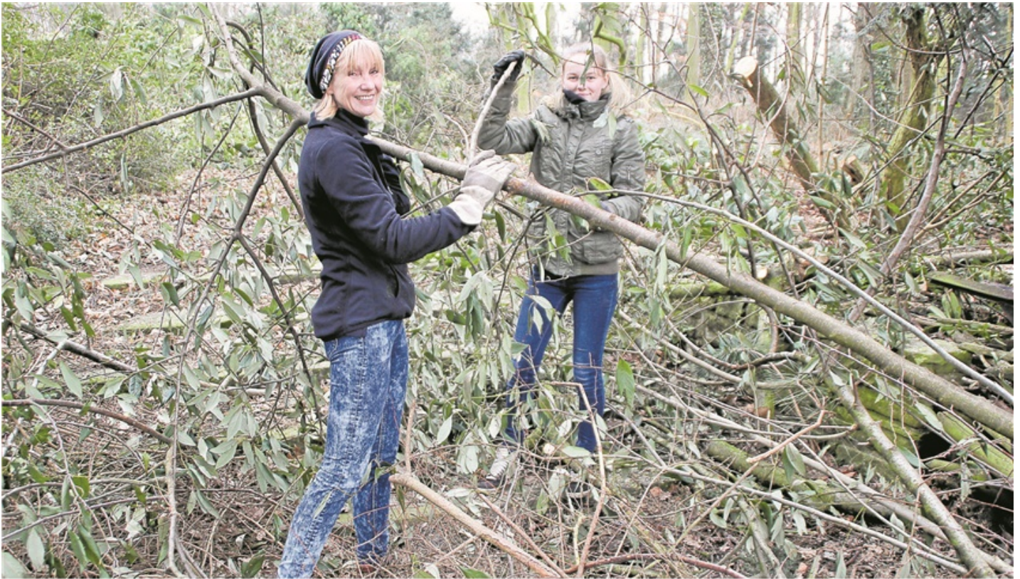
Karin Syrbe (l.) und Johanna Diekmann packten bei den Arbeiten im Volkspark Brambauer kräftig mit an. Auch ohne großes Equipment. Für andere Arbeiten musste jedoch schweres Gerät hergeschafft werden.
