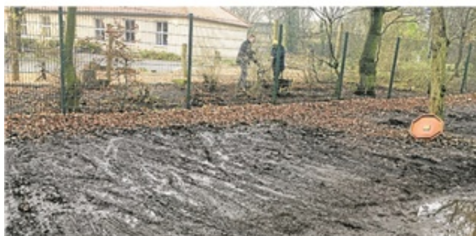
Parken im Matsch vor dem Zaun. Dahinter die Schule Förderzentrum Nord.
